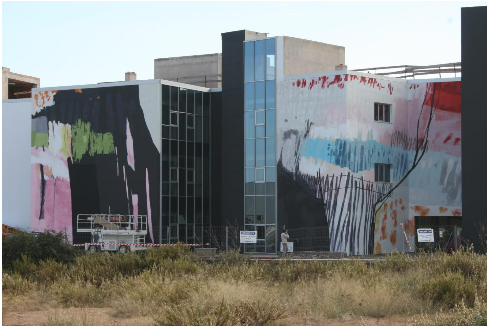
Fachada hotel Alquilerías del Niño Perdido. Cara norte.
