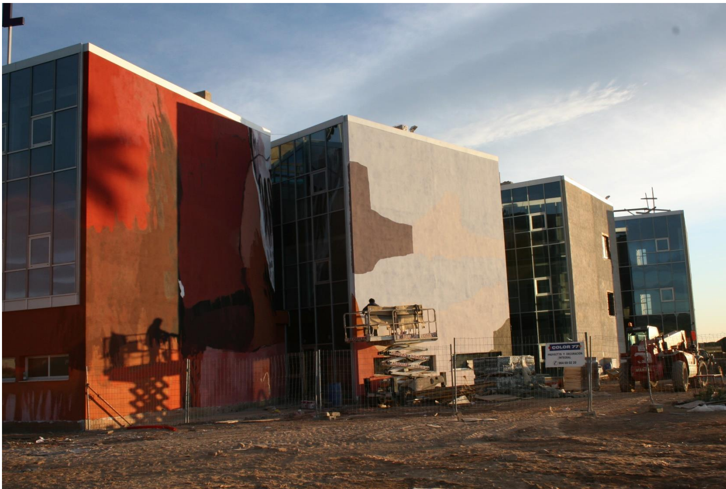
Fachada hotel Alquilerías del Niño Perdido. Cara sur.
